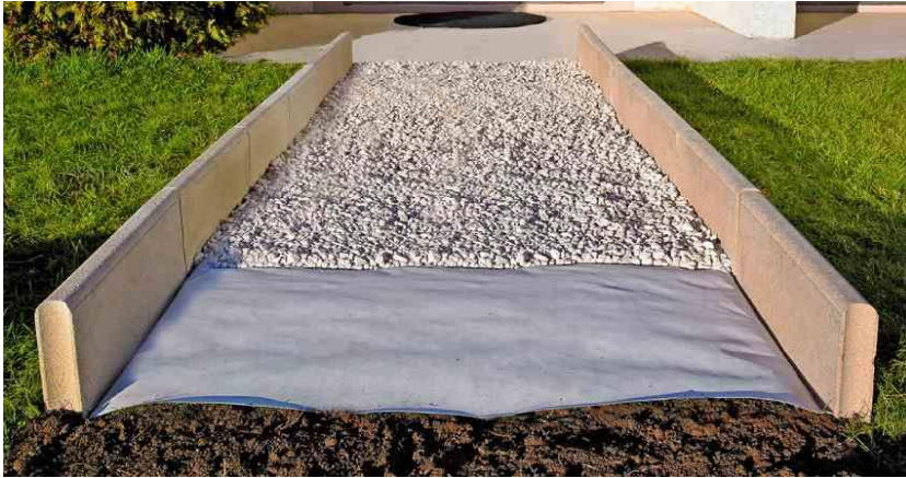
Figure 4 Pose d'un feutre géotextile recouvert de gravier avec bordures délimitant le gazon. ©Jardincouvert
